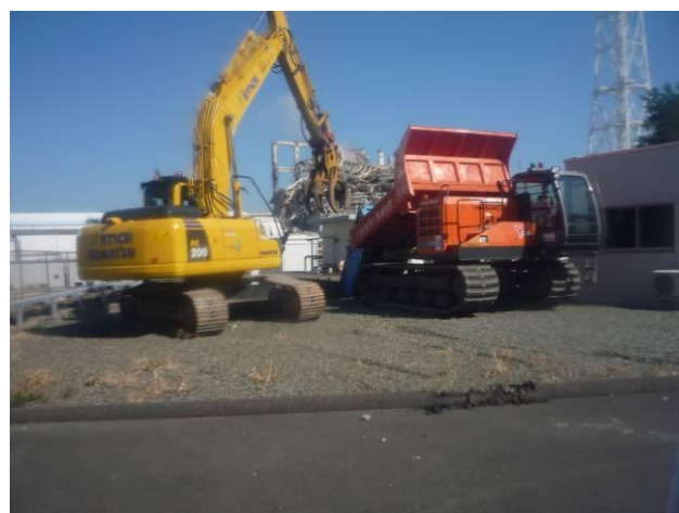
仮置き場定置作業
